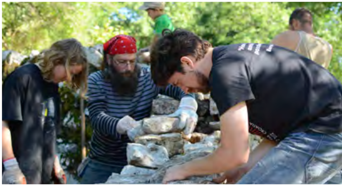
Petrebisća: wznoszenie i odnawianie murów z kamienia bez użycia zaprawy, 2014. Fot. Nevena Kereša, © Association 4 grada Dragodid.
