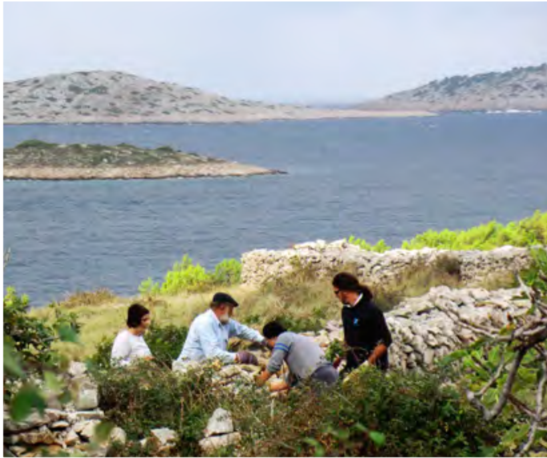
Kornati: wznoszenie i odnawianie murów z kamienia bez użycia zaprawy, 2015. Fot. Vilma Stopfer, © Association 4 grada Dragodid.
